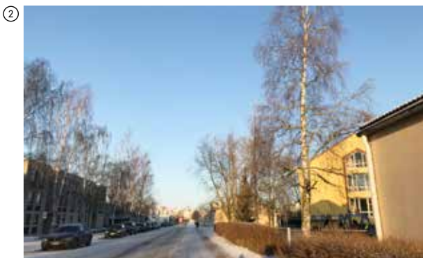
↑ Vanhan koulurakennuksen eteläpääty on suunnattu Kansakoulunkadun suuntaan. Vastapäätä katua on harmaita, vuonna 1979 rakennettuja laatikkomaisia betonielementtikerrostaloja. Katua reunustavat korkeat koivut ja paikoin pensasistutukset.
